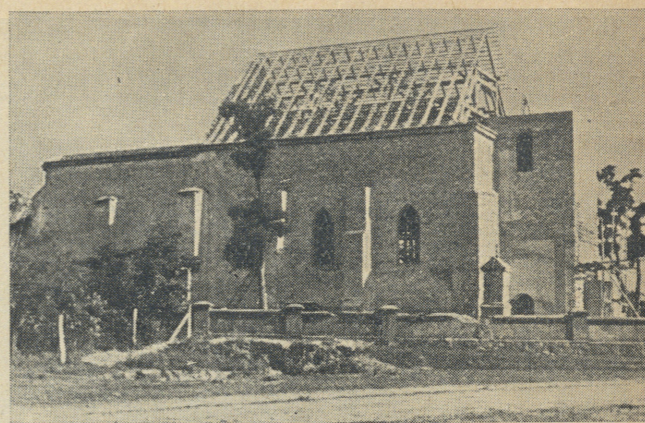
Pomiechowo — kościół z XV w. w czasie odbudowy.
