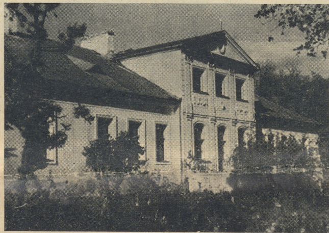
Dębinki — pałac z poł. XVIII w., elewacja ogrodowa po odbudowie, obecnie przeznaczony na Dom Dziecka.
