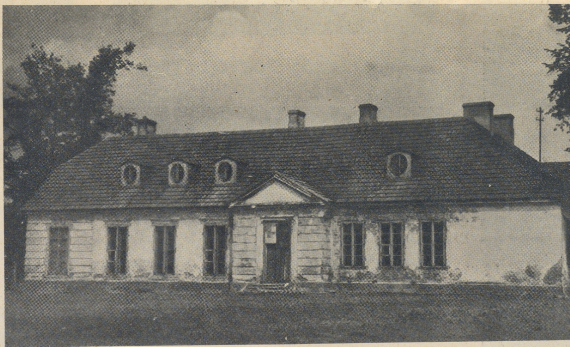
Jordanowice — dwór z XVIII w. po odbudowie dla Zeńskiej Szkoły Krawieckiej.
