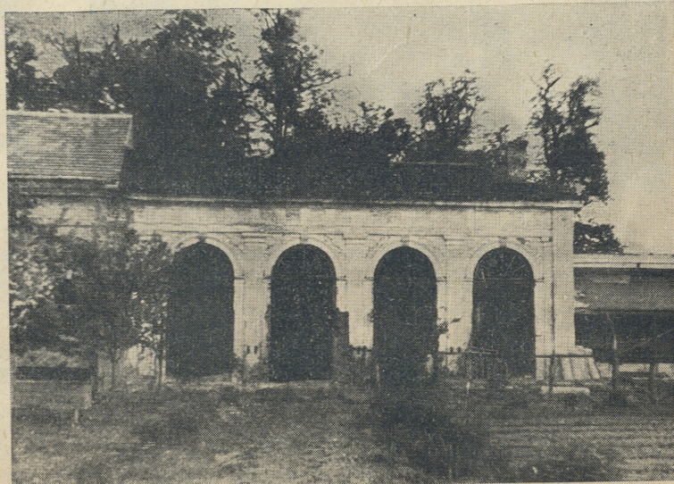
Młochów — oranżeria w czasie odbudowy.
