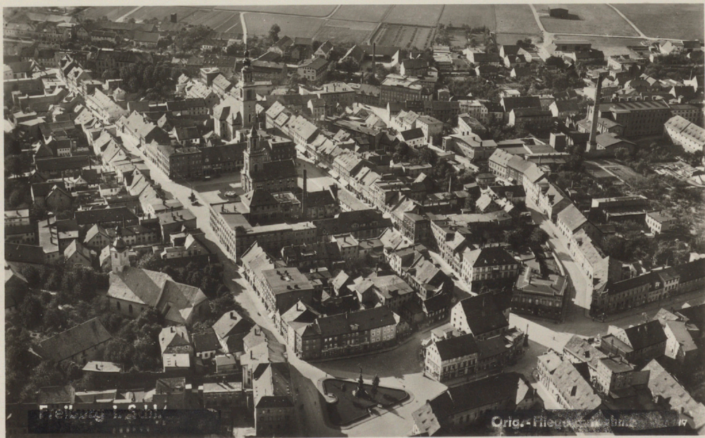
D/Sl. Swiebodzice—Widok z lotu ptaka
