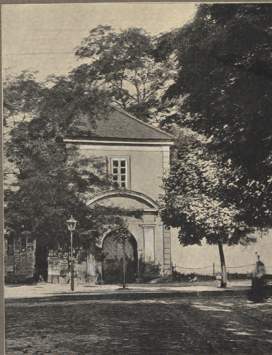
Rys. 69. »Bazta Kościuszki« przy ul. Podwale w Krakowie, zburzona w październiku 1909 r. E. Łuski „W Odr. P. K.”
