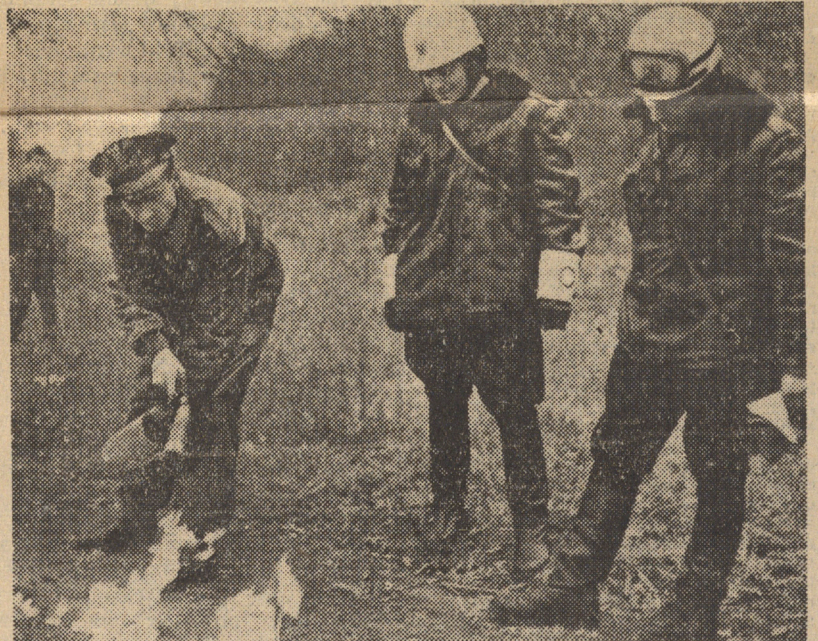
Tajemnicze szczeliny przy szosie Kraków — Przemysł. Wydobywający się gazy ziemny został zapalony przez członków komisji specjalistów.
