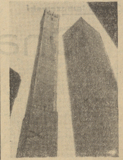
Dwie krzywe wieże na placu w Bolonii. Większa (Torre Asinelli) wysoka 97,6 m; z wychyleniem 1,2 m od pionu. — Mniejsza (Torre Garisenda) ma 4,75 m wysokości, a odchylenie 2,4 m.
