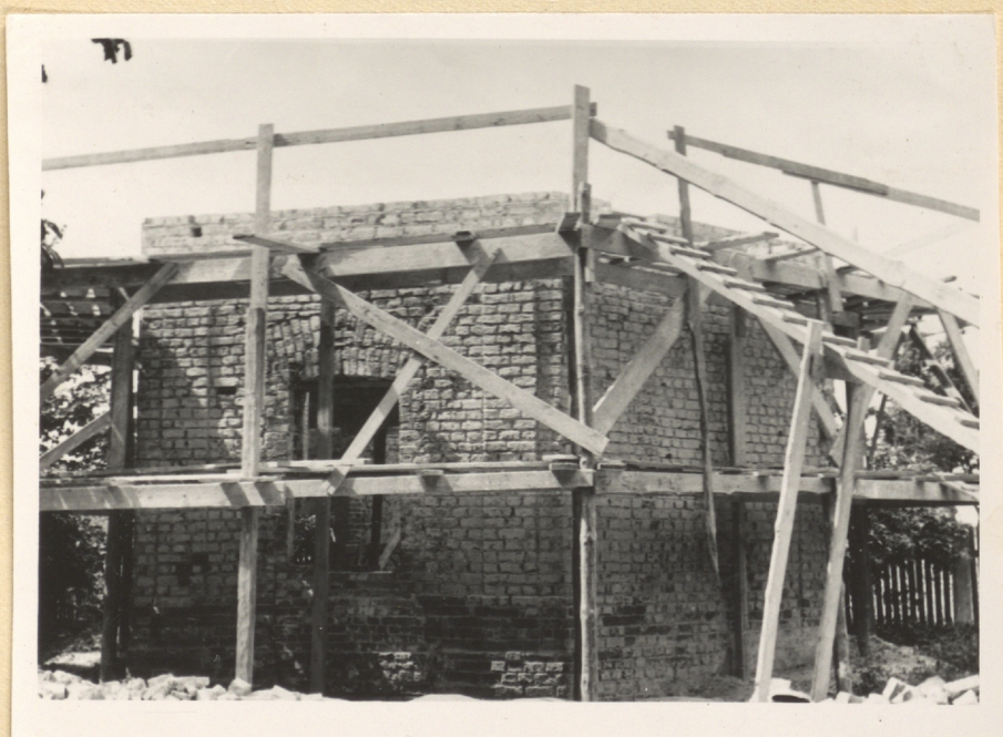
Puławy- prace przy altanie chińskiej
