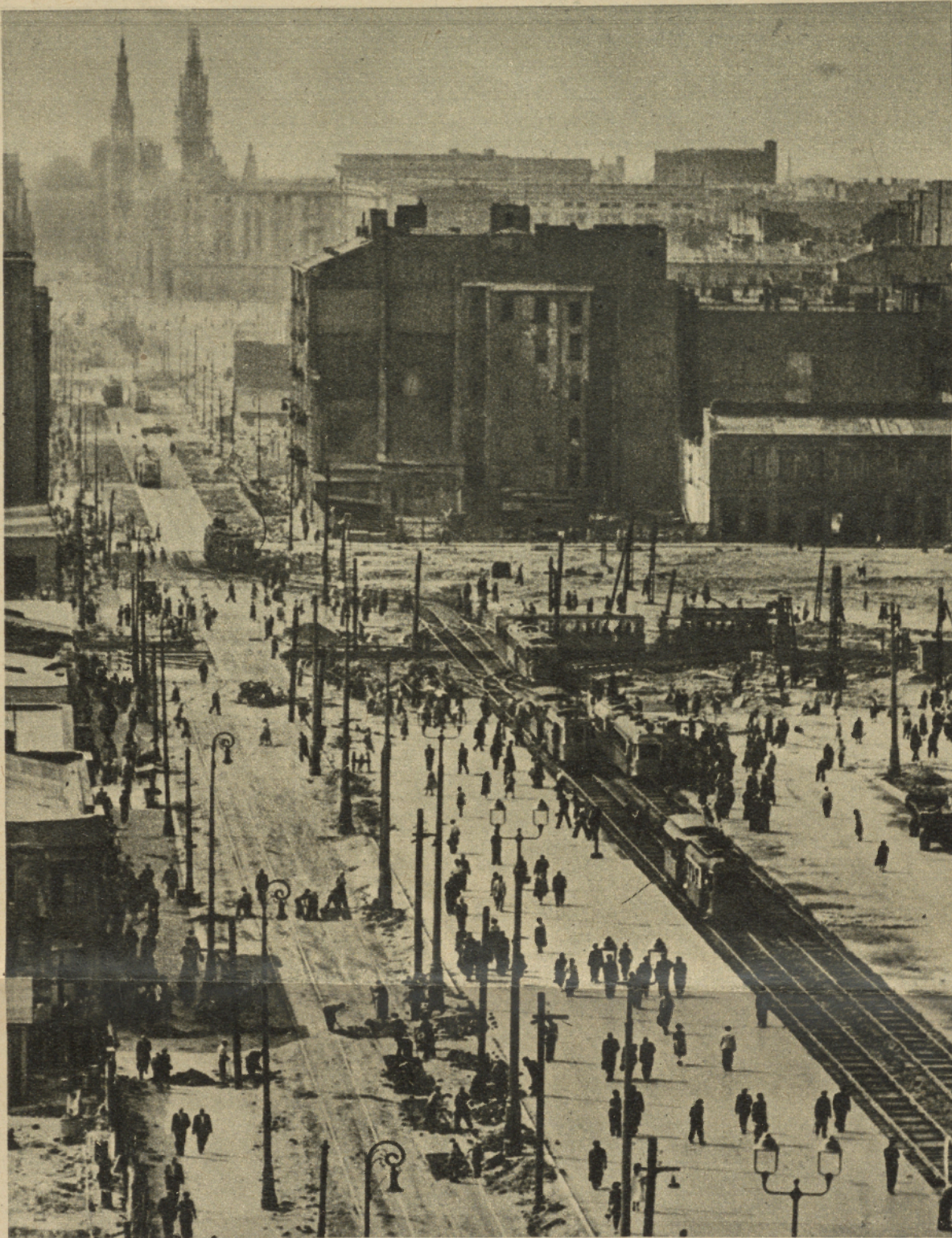
Skrzyżowanie Marszałkowskiej z alejami Jerozolimskimi w dniu 8-go lipca br. Zmontowano już gwiazdasty rozjazd dla tramwajów. Oczyszczono narożnik, na którym stał niegdyś dom architekta Marconiego. Dalej w kierunku placu Konstytucji widzimy wielką, ciemną bryłę kamienicy na rogu Żurawiej, która jest w stadium rozbiórki. Jeszcze dalej — gotowy dla przeprowadzenia nowej trasy teren, na którym stały przed 1939 r. czynszówki. Na planie ostatnim — domy pl. Konstytucji i kościół Zbawiciela. Fot. A. Funkiewicz
