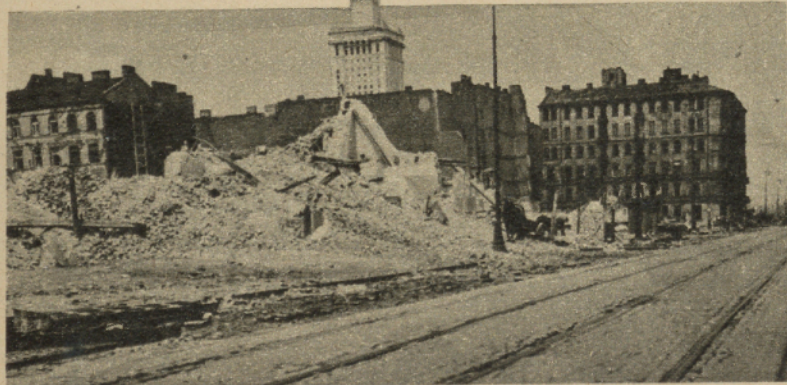
Z rogu ulicy Hożej i Marszałkowskiej (strona parzysta) oglądamy resztki kamienic między Hożą i Wspólną i wielką czynszówkę na rogu Żurawiej, która zostanie rozebrana, gdyż znalazła się na linii nowej, poszerzonej przeszło dwukrotnie, ul. Marszałkowskiej.
