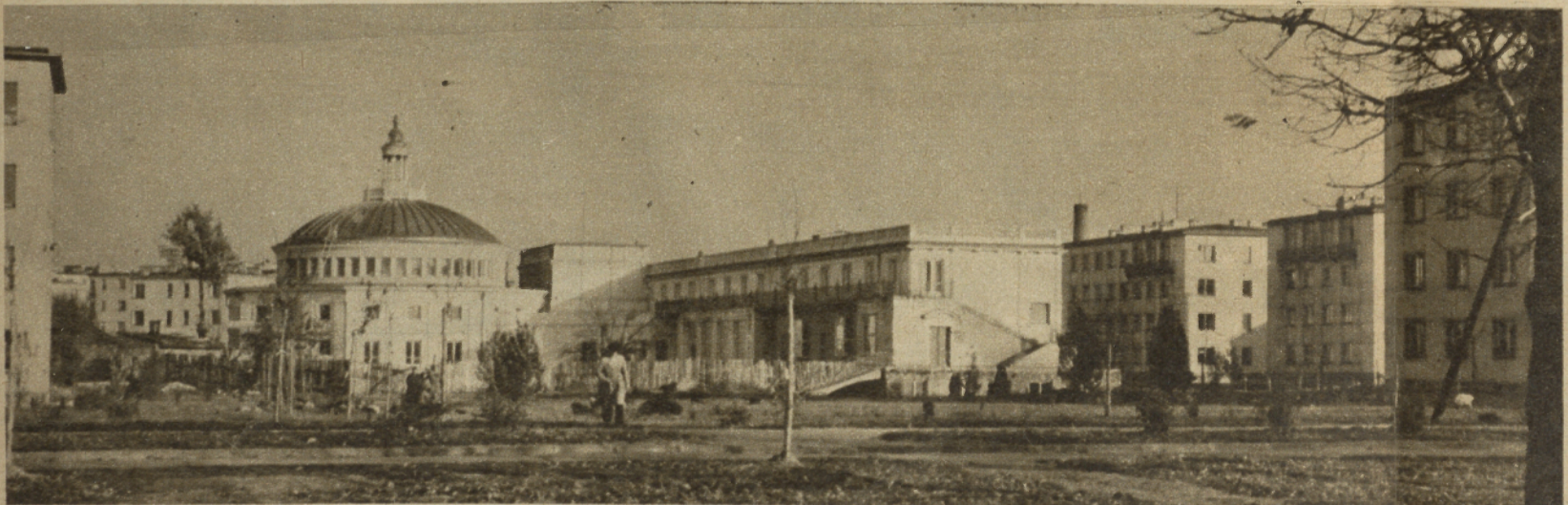
Kompleks teatru i Domu Kultury na Żoliborzu był pomyślany i zaprojektowany jako jedna całość. Stąd dla teatru, który miał być teatrem dla zespołu amatorskiego, a nie dla zespołu zawodowego, nie przewidywano koniecznego zaplecza. Po „separacji” nastąpiły przeróbki.
