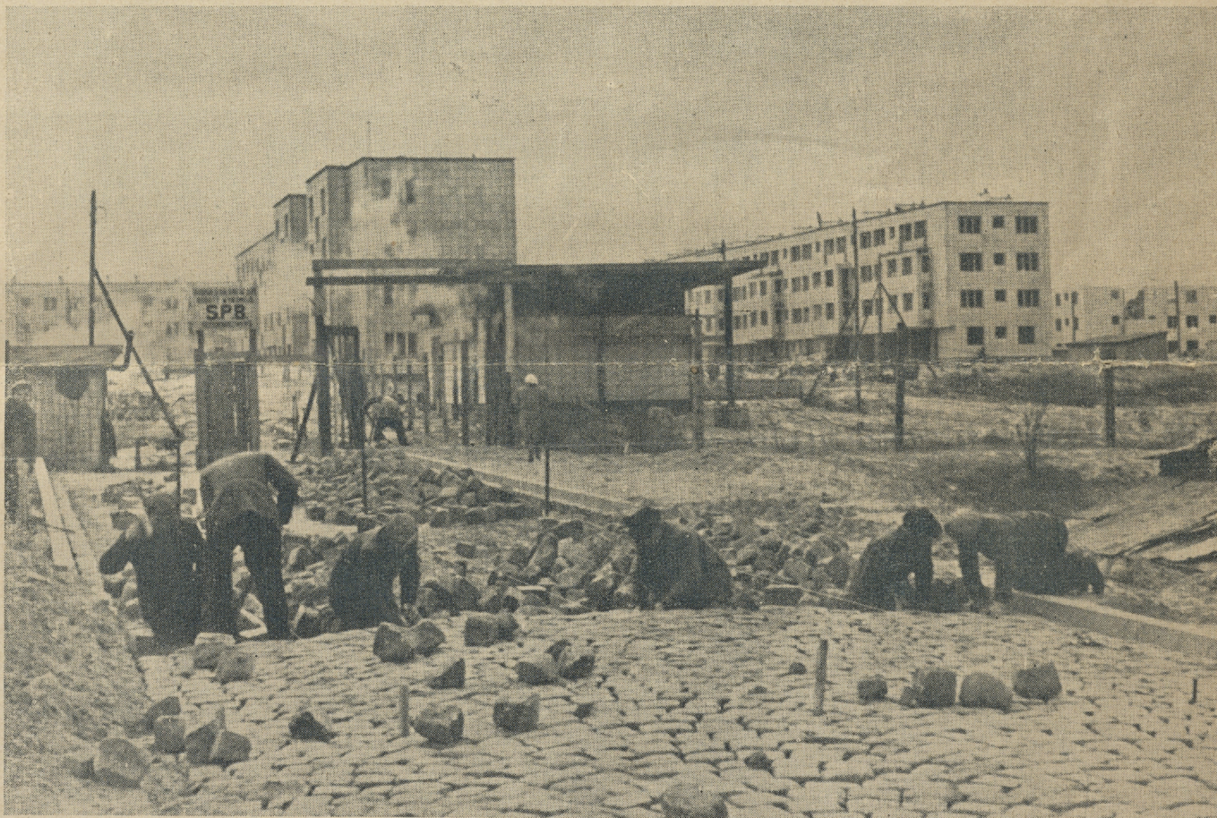
Do bloków mieszkalnych na Kole SPB wykonuje nową jezdnię
