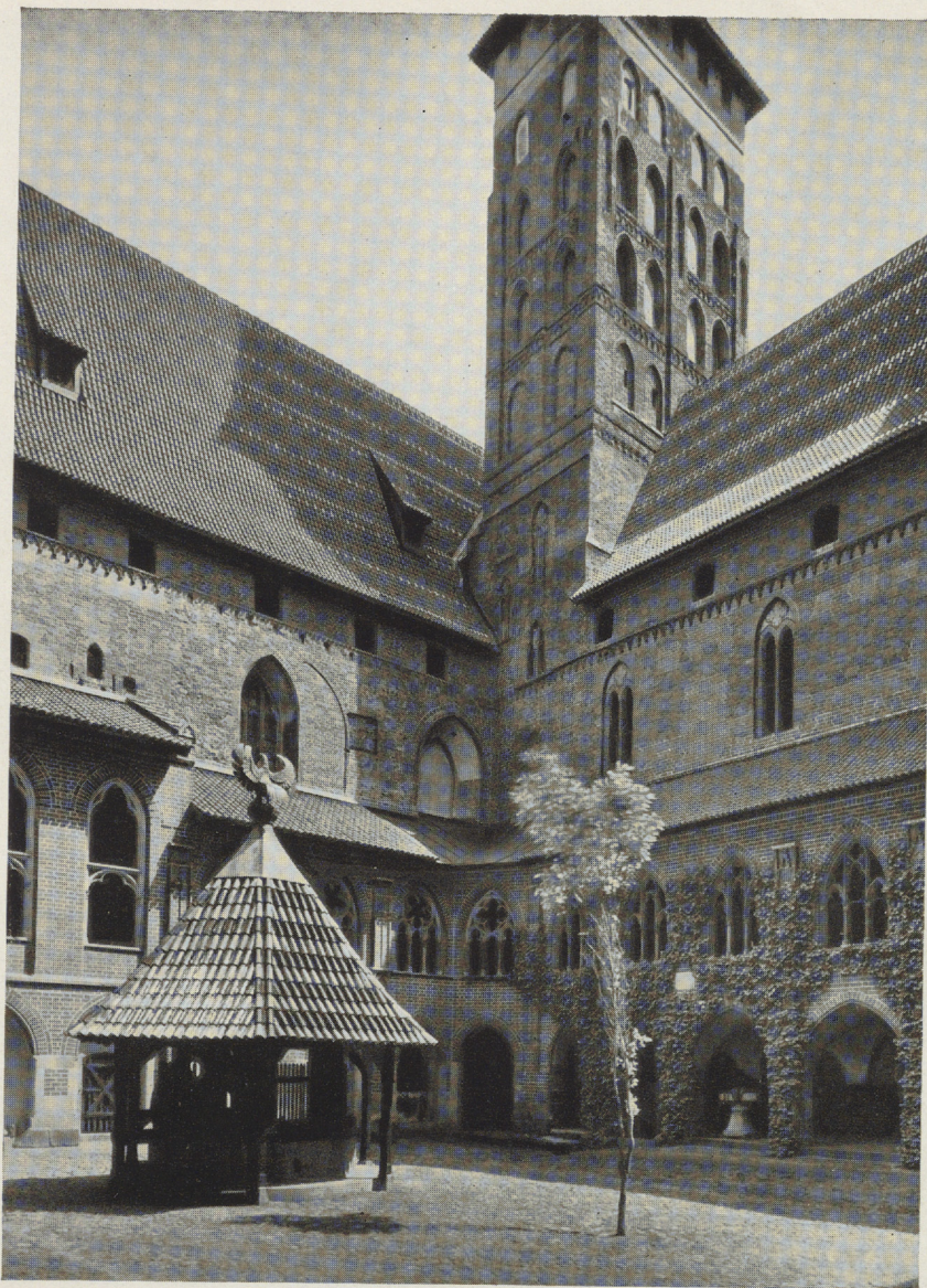
Hochschloß, Nordostecke des Hofes
