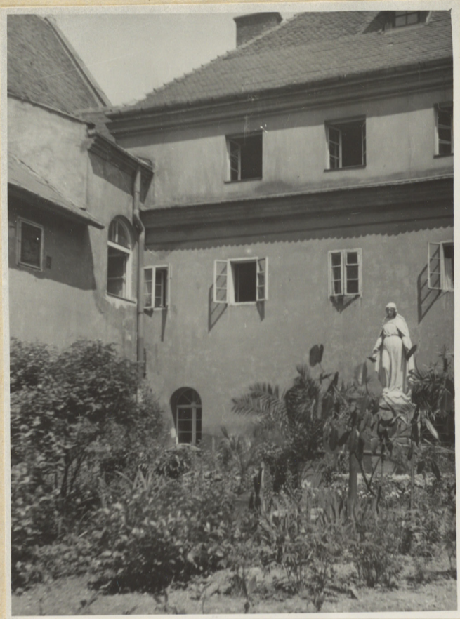
Kraków - Reformacji Wirydarz - fot. G. Lisicki
